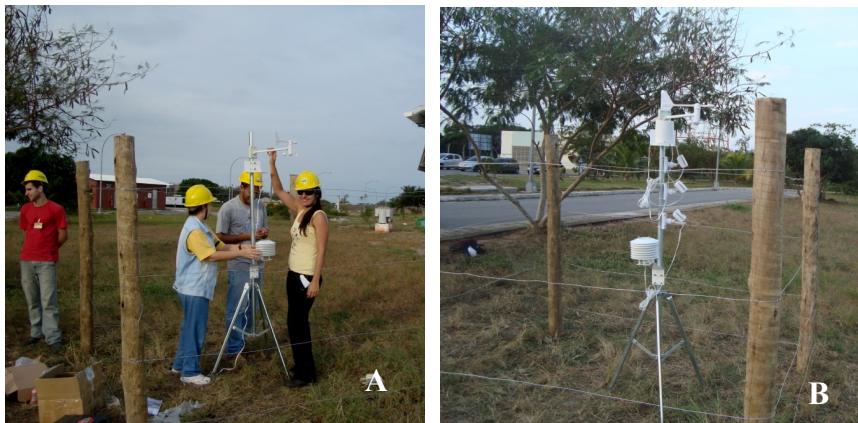
Figuras 3 A-B. Instalação da Estação Meteorológica em Quissamã, RJ.
